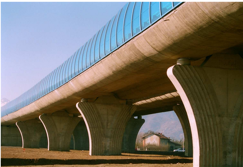
Sovrappasso autostradale nei pressi di Pinerolo (TO).
