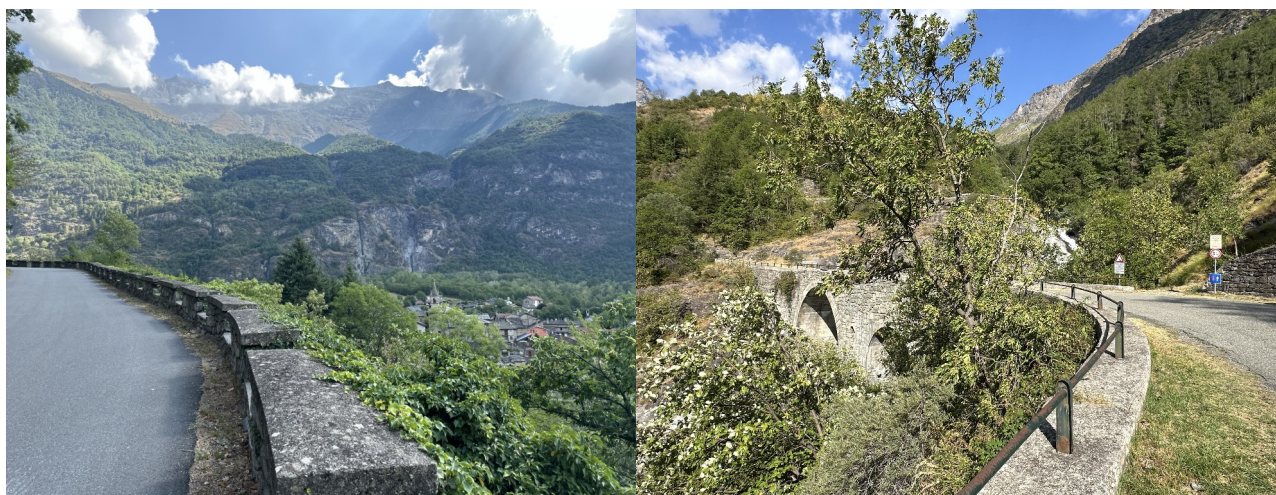
Alcuni tratti della panoramica e antica Strada Reale che da Novalesa sale a Moncenisio; a sinistra scorcio del paese di Novalesa con le sue cascate e, a destra, ponte con tre archi in pietra lungo la salita
