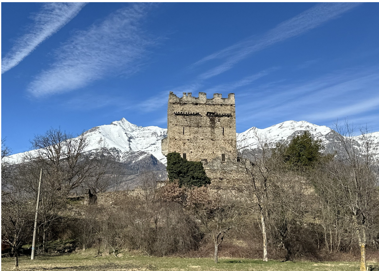
La Casaforte medievale di Menolzio costruita su uno sperone roccioso
