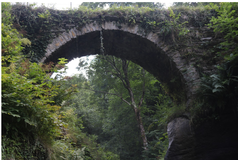
Il ponte del Rampign
