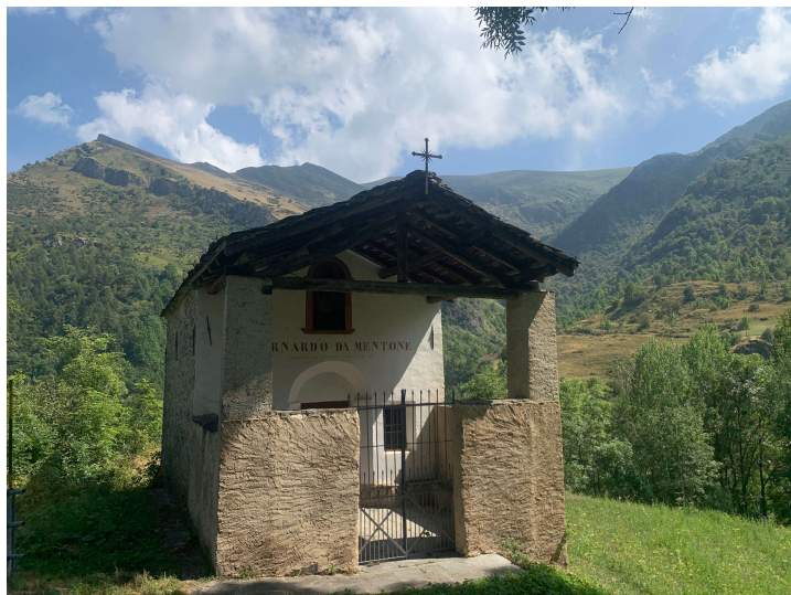
La cappella di San Bernardo da Mentone lungo la strada per il santuario di Castelmagno
