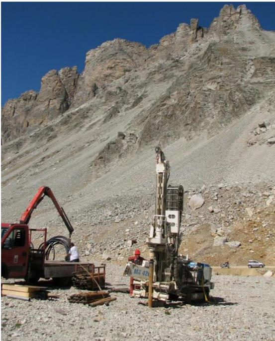
Perforazione del pozzo di 100 m di profondità
